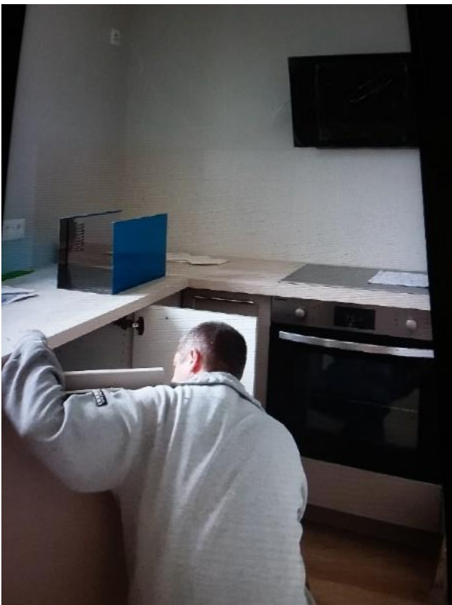
Bruno installe la nouvelle cuisine
